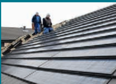
KoraSun® fotovoltaïsche zonnepanelen voor naadloze integratie in Koramic kleidakpannen
