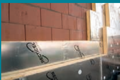
Eurowall®, de smalste spouwisolatie + Porothersm binnenmuurstenen
