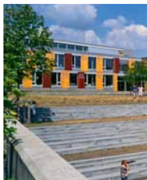
École primaire de Riedberg , Francfort-sur-le-Main (Allemagne) 4a Architekten | Photos Riedberg 1 & 2 : source : Ville de Francfort-sur-le-Main Cette école, réceptionnée en 2004, a été la première école primaire complètement aménagée selon le standard passif en Allemagne. Ce bâtiment compact, d'une superficie de 8 785 m 2 , permet d'accueillir 400 élèves et 125 enfants de 4 à 6 ans. Un système de ventilation contrôlée avec récupération de chaleur centralisé est complété par des petits appareils de chauffage placés en appont dans chaque local. Deux poêles à pellets entièrement automatiques de 60kW fournissent la demande de chaleur restante.
