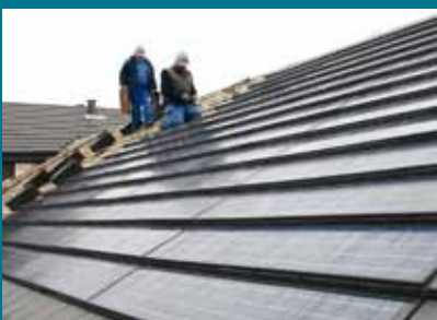
Panneaux photovoltaïques KoraSun® parfaitement intégrés aux tuiles terre cuite Koramic
