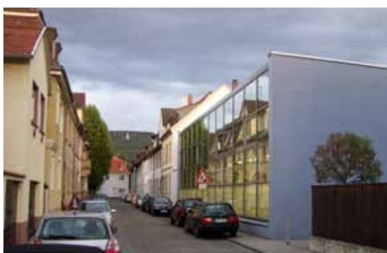
Salle de sport dans la Kurpfalzschule de Heidelberg (Allemagne) ap88architekten | Photos : PHP
