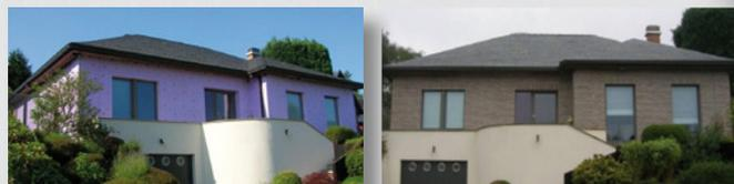
Waterwerende xps platen met tand en groefstelsel zorgen voor een gevel **zonder koude bruggen**, flexibele lijm en aangepaste schroeven worden gebruikt voor een levenslange bevestiging, een bijna oneindige keuze aan steenstrips en voegmortel zorgen voor een perfecte afwerking naar ieders smaak.
