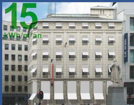
15 kWh/m 2 an [176] rénovation Green Arch, www.greenarch.be Rue Royale 94 (privé, 2.229 m 2 )
