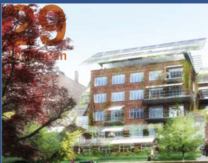
29 kWh/m 2 an [171] rénovation Ateliers Jean Nouvel & MDW architecture Rénovation Chaussée de Vleurgat (Area Real Estate, 3.360 m 2 )
