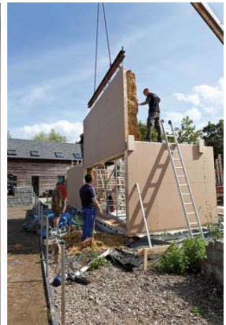
3 Préfabrication de module en paille par Paille-Tech [Source : www.pailletech.be ]
