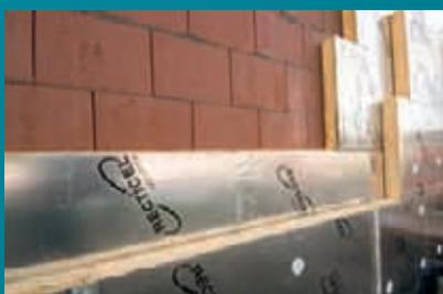
*Eurowall®, l'isolation des murs creux la plus mince + blocs pour murs intérieurs Porotherm*
