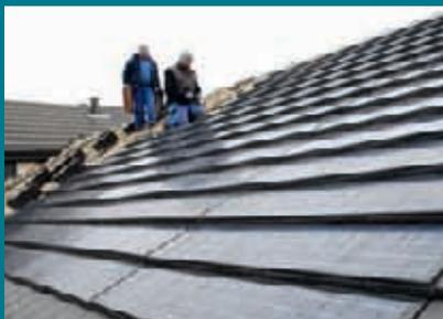
*Panneaux photovoltaïques KoraSun® parfaitement intégrés aux tuiles terre cuite Koramic*
