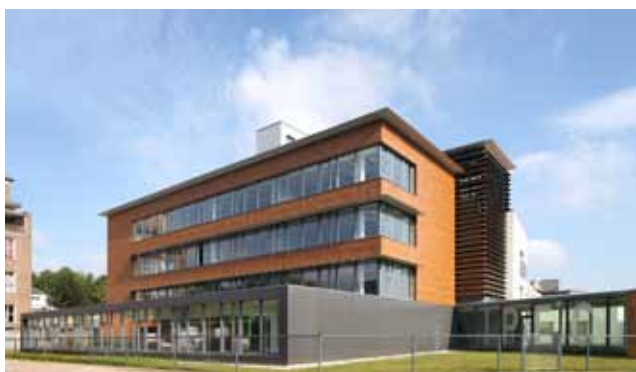
Institut Provincial d'Enseignement de Promotion sociale et de Formation continue (IPFC) te Nijvel (België) Architect : A2M | Studie bureau Cenergie | Foto : Filip Dujardin
