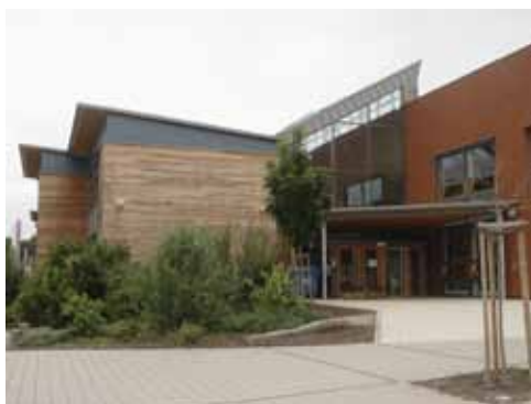
Schoolcomplex te Roodt-sur-Syre, in Betzdorf (Luxembourg) Marc Dieschbourg Architectes S.A. | Foto : PHP
