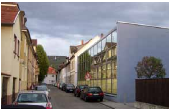
Sporthal in de Kurpfalzschule te Heidelberg (Duitsland) ap88architekten | Foto : PHP
