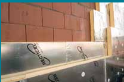
Eurowall®, de smalste spouwisolatie + Porotherm binnenmuurstenen
