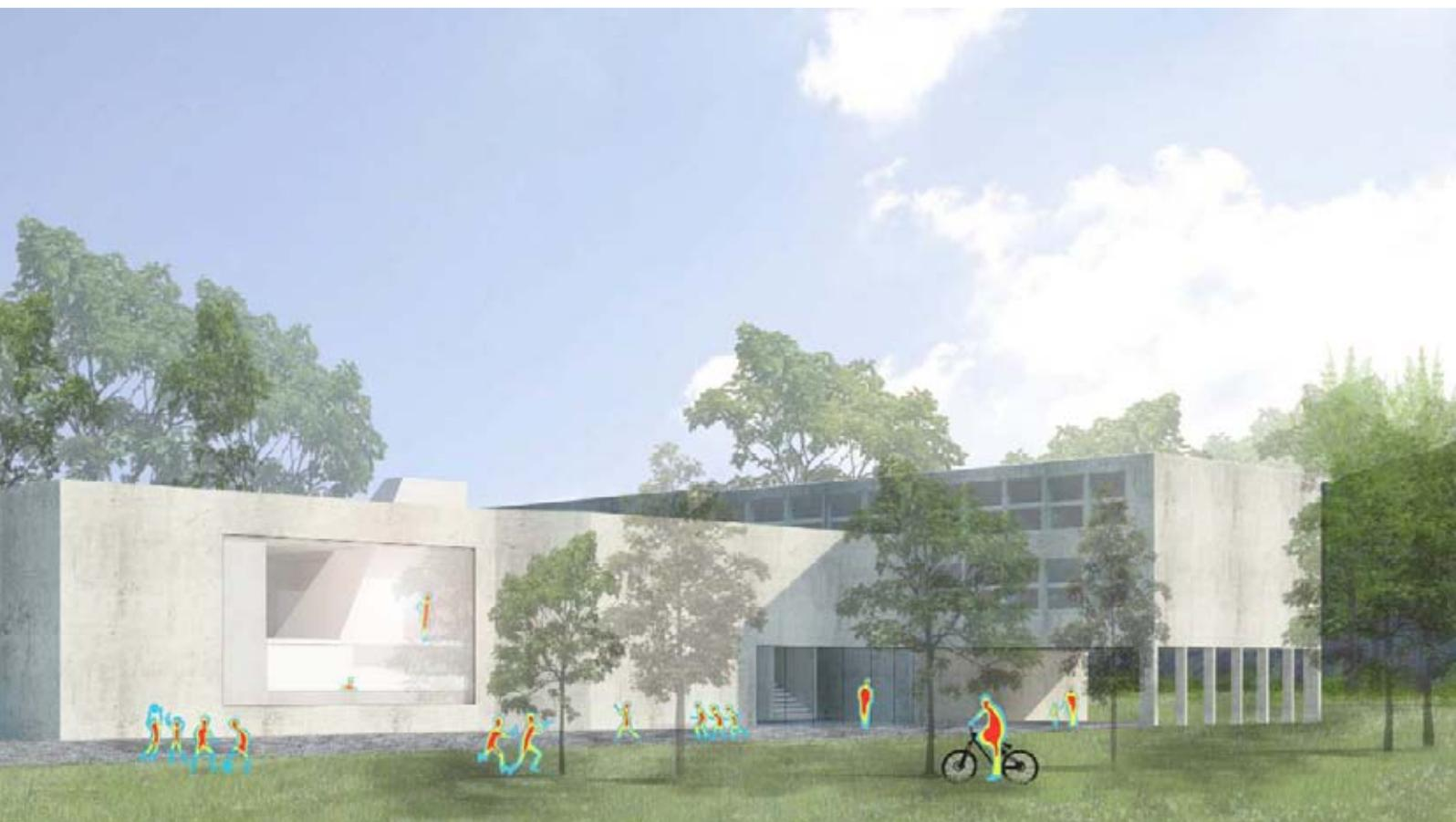
l'isolation thermique extérieure ne permet plus de montrer en façade le système porteur du bâtiment. Pour éviter les ponts thermiques, le système porteur vertical et horizontal, c'est-à-dire les colonnes, les murs, les dalles de béton armé ou d'acier, est relégué à l'intérieur de l'enveloppe isolante, cachée à la vue depuis l'extérieur.
